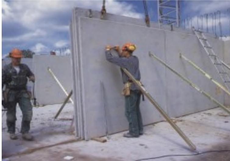
Handliche, leichte Wandstütze für die Montage von Fertigbauwänden, Innenwänden, Holzwänden etc.
